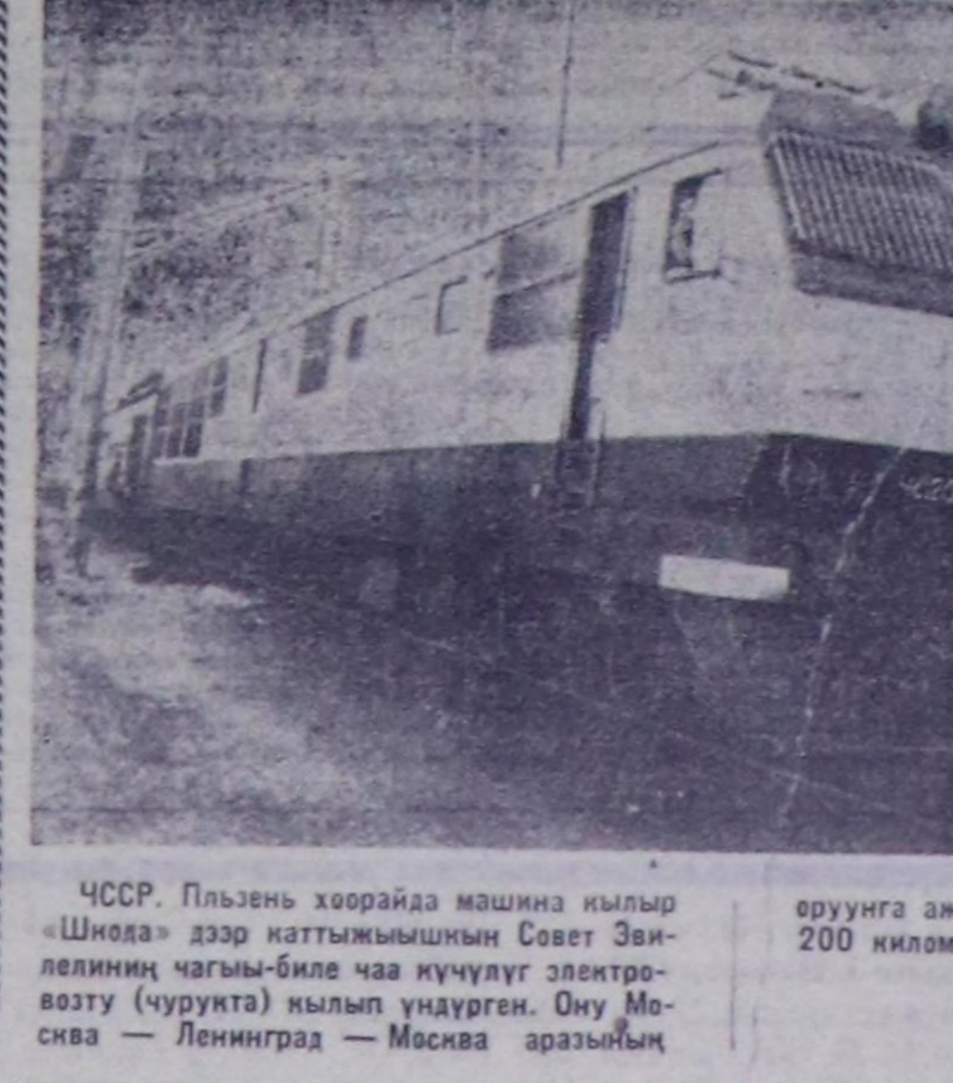
ЧССР, Пельнея хоорайда машина кылыр «Шнода» дээр каттыжыштын Совет Зелдиниң чагы-биле чаа күнүлүг электро-волту (чурукту) кылып үндүргөн. Ону Мо-сква — Ленинград — Москва аразының оруунга ажыглаар деп турар. Ол шапта-ла 200 километр дүргөн маңнап, составты сөөртүп шылаар.
