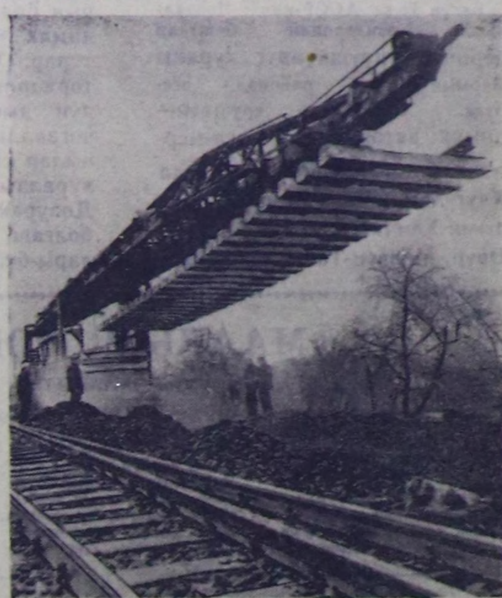
Магдебуртун демір-орук тудугжулары Совет Эвилелин-ден релсе салыр тускай машиналар алганнар. Он ачымында ажилчыларның күжүн камнаар болган демір-орукту салырын дүргөдөп.
