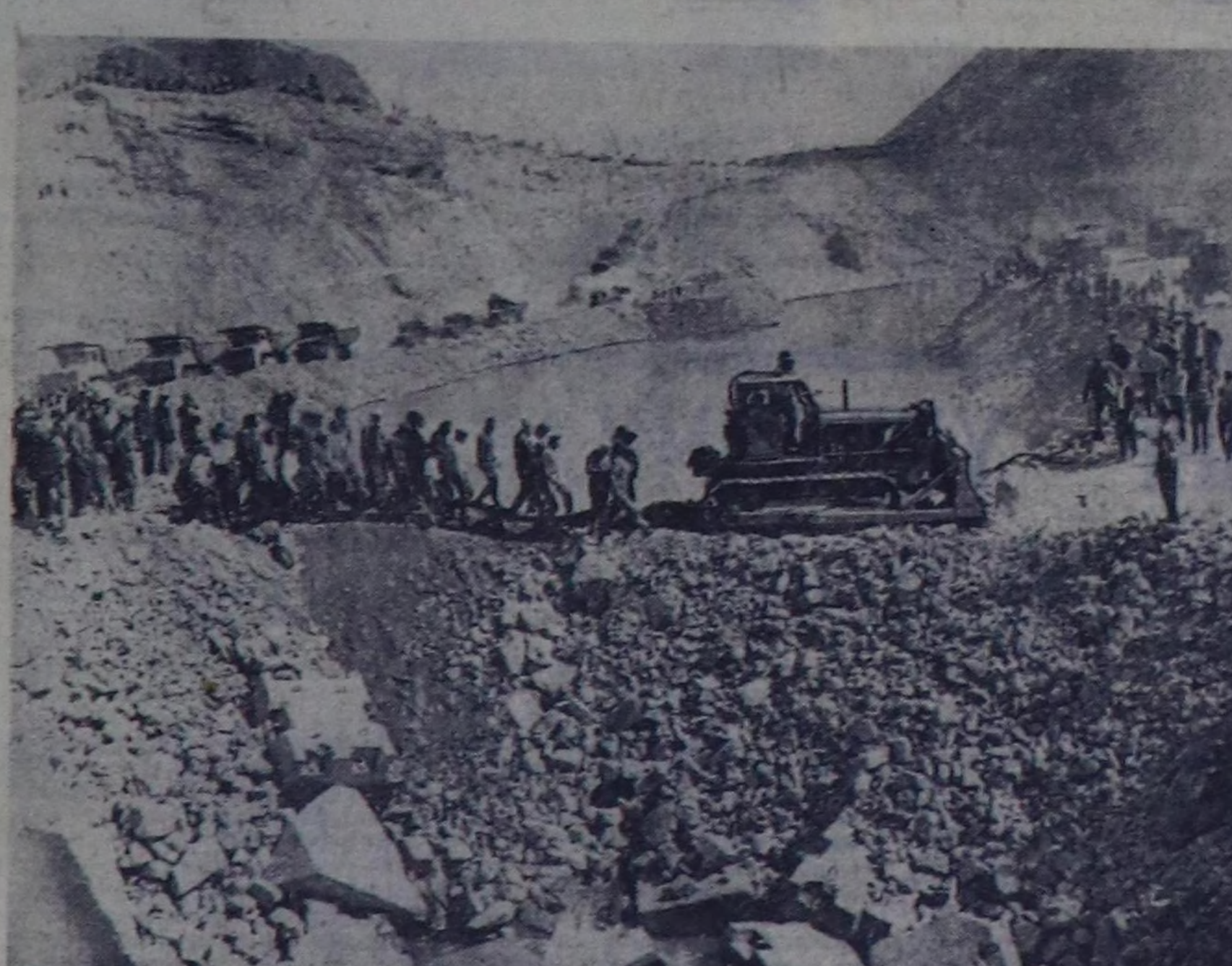
Узбек ССР. Даг хами Чирчик цум солун- кан. Чарвактын гидроэнергетиктиг бедирини тубуштарынын он ийн шак дүрүзүндө бедирин салып үндүргөн даш моондаан барып шаштыккан, шалкын агым чалым халарын өтүр өрүмүн 780 метр тоннель таварты агып баткан. 600 муу киловатт күчүлүг электро- станцияны болгаш улуг суг хөөлбөз түдүп ту- рат. Тянь-Шаньны чыгарында тубушун баш- тайы эл-чыл ыччалары доозулган.
