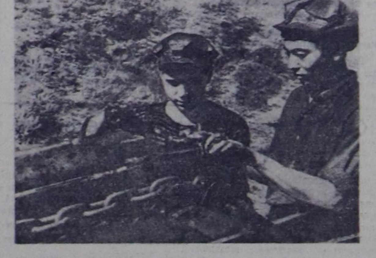
ЧУРКУТА: электрослесарьлар А. Кузнецов биле С. Доржу бир шахта штилинде 250 тонна хөмүр дашты үндүрүш «СП-63» деп конвейерни монтаждап туралар.
