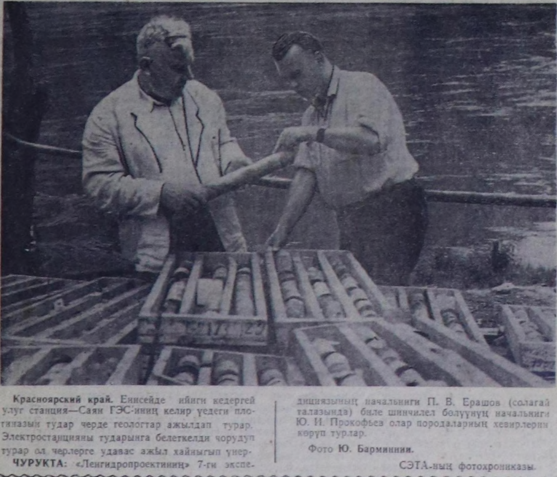
Красноярский край. Енисейде ийн кедергей улуг станицы—Саян ГЭС-иниң келир үдети плантынын тулар черде геологтар ажыдал турар. Электростанцияны туларга белгеледи чорудуур ол черлерге удаас ажыл хайынгы үнер-ЧУРУКТА: «Ленгидропроектиниң» 7-ги экспедициянын начальниги П. В. Ерашов (солгай талазында) биле шенчилел болуучу начальниги Ю. Н. Прокофьев олар породаарының хевиртерин көрүп турар. Фото Ю. Барминини.
