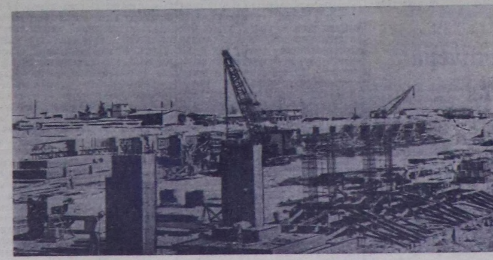
Кубада эң күчүлүг электростанциянын курулушунун башталышы.
