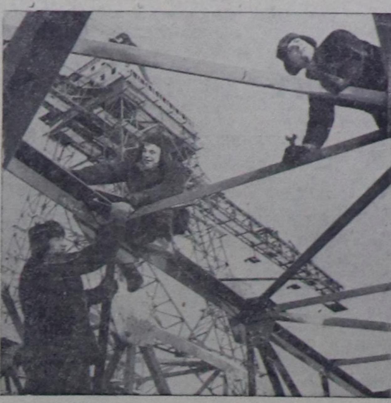
Иркутск область, Братск ГЭС-тиң плотиназынга болгаш станцияның бажыныга бетон көдүртүп уурагына амылдар ийи талалыг краннарың элтежиңиң эзелен. Бо амылду Никитичев, Соловьевтар болгаш Олейниковтар эптекчилер бригадалары күсезип турар. Ол кранны бедин 24 кельт бажың-биле ден болгаш 22 тоннаны көдүрер аргалыг. Ындыг кранлар 6 болуп.
