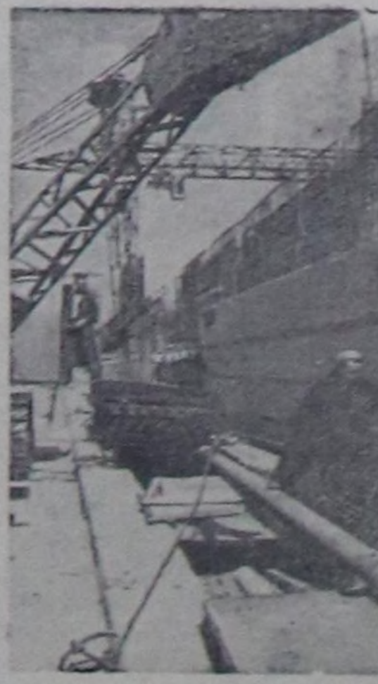
Воронеж атомнуг электростанциянын туудуунда Арматураны элтеп турары.
