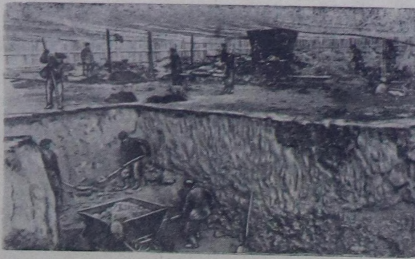
Эрбектин шахта өргөлөи Элегес-Аксы суураа 500 киловатт күштүг электри станциязын бо чылдын түдүп ажылаага кириер. Электри станциязы суурун чурттагыларын болгаш Элегес болгаш Кызыл-Хавак шахталарын хандырар. Станциянын түдүгүндө даш чыдыган болгаш 130 кубометр фундамент салдыган. Түдүгүндө Петр Григорьевич Косоровтун чер казар бригаданы база дашчылар П. Тонких, Н. Смирнов, И. Селин олар эки ажылап турар. Чуртка: электри станциязынын түдүгүнүн. Фото В. Лутковтун.
