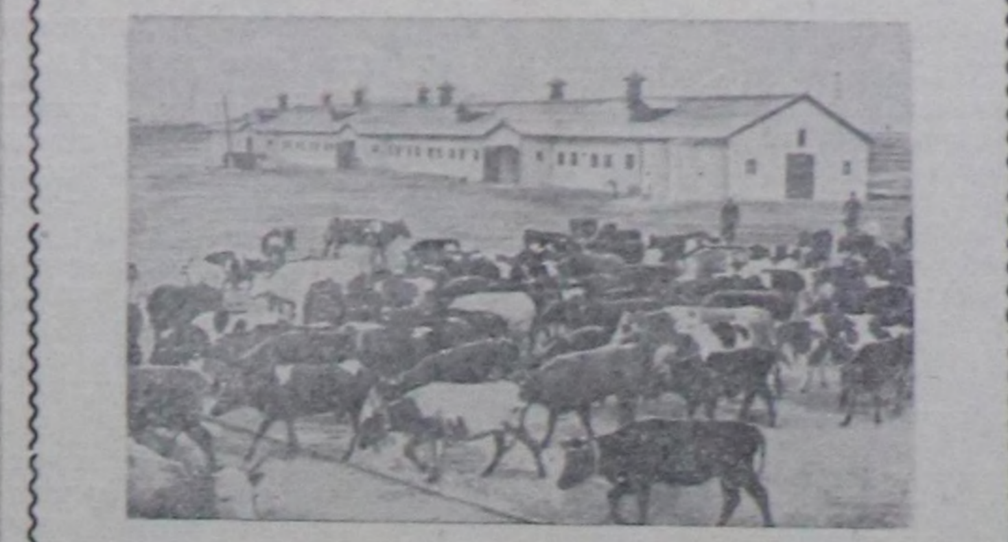
«Бузовнынефть» трестиниң нефтичилери Бузовны суурда Киров аттыг колхозка илек кажааны туларында дузлашкан. Мында автосаалдымы, асымың өрүктү, электр чырылгыламы кылган. Чурукта: Киров аттыг колхозка нефтичилериниң түлүп берген чаз кажааны. Фото Ф. Шацкостуу.
