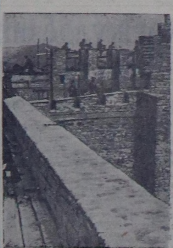
Кызылдың септелге механик заводунун чылыг күжү-биле ажилдаар электрстанциясынын тудуу. Чуруу А. Ермолаевтин.
