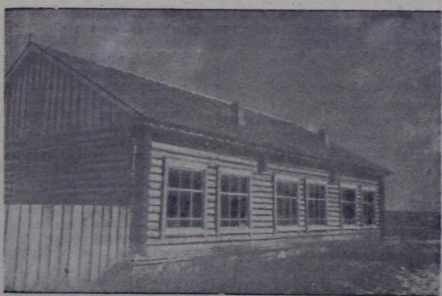
Танды районун Бай-Хаакта ыяш ажал-агыый чазанылга херекселдер цехинин улуг бажынын туткан. Чазанылга цехи амгы үеде школа столдары болгаш самбыралар кылырының чагыын күүседип турар. Район куну культура бажынынга херек б5 кезек диваннары кылырынче база удаас кириптерлер.
